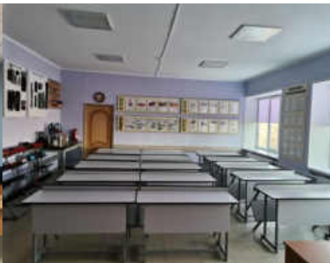
Ремонт кабинета Л-302
