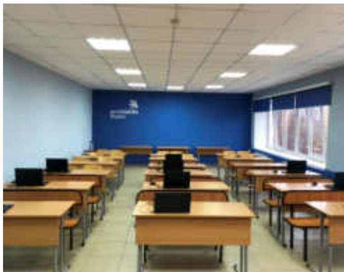
Ремонт кабинета Л-304
